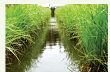
다공질 콘크리트 수로 (시공 후 1년)
